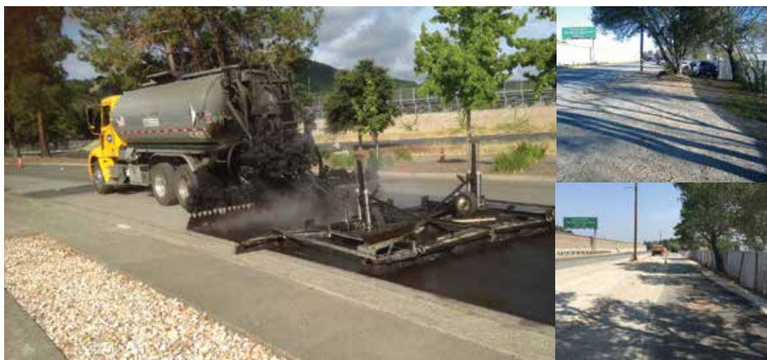
(En sentido horario) 1. Repavimentando. 2. Sendero Nave Drive, antes. 3. Nave Drive, en construcción.
